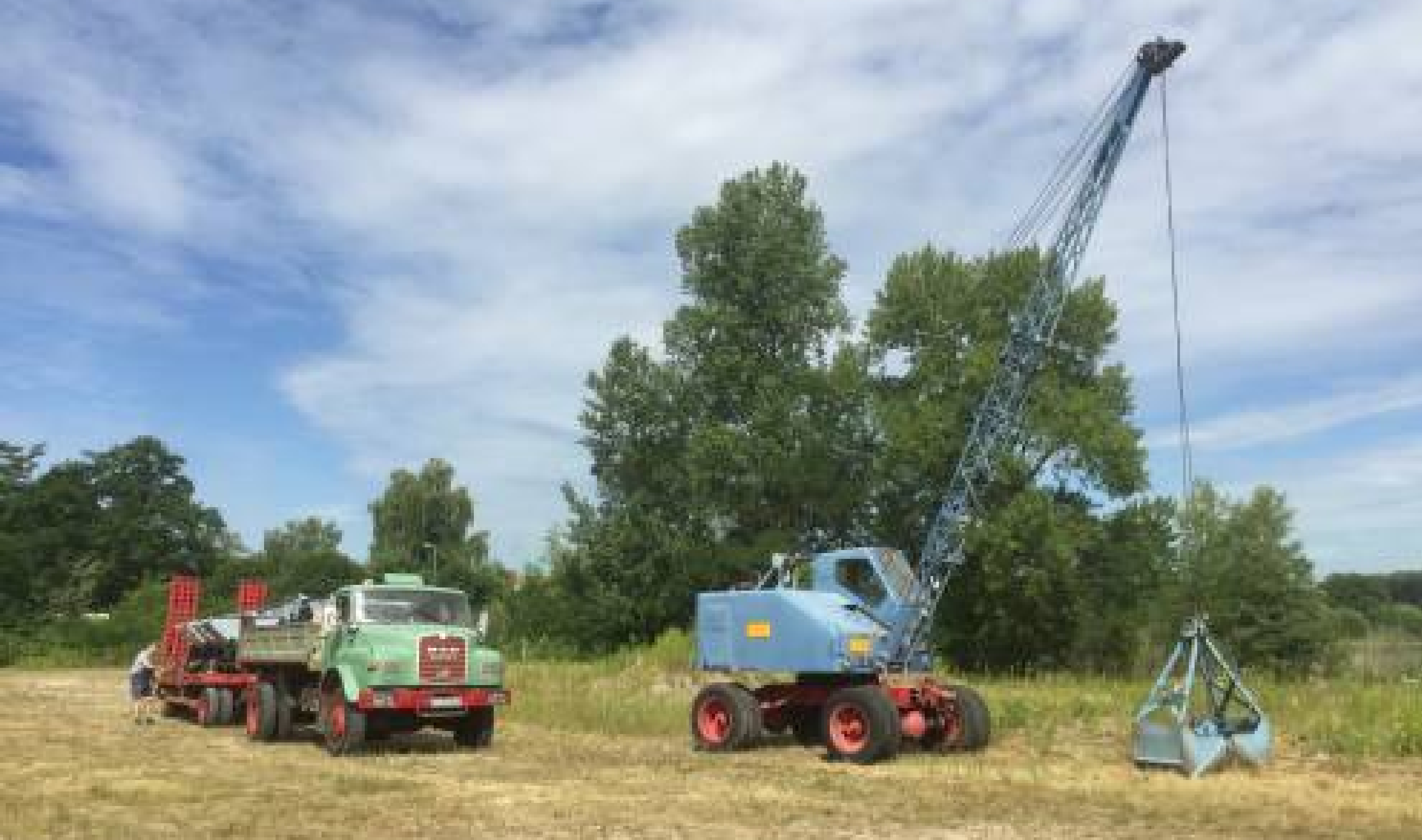
Aufbau historische Baustelle 2019
