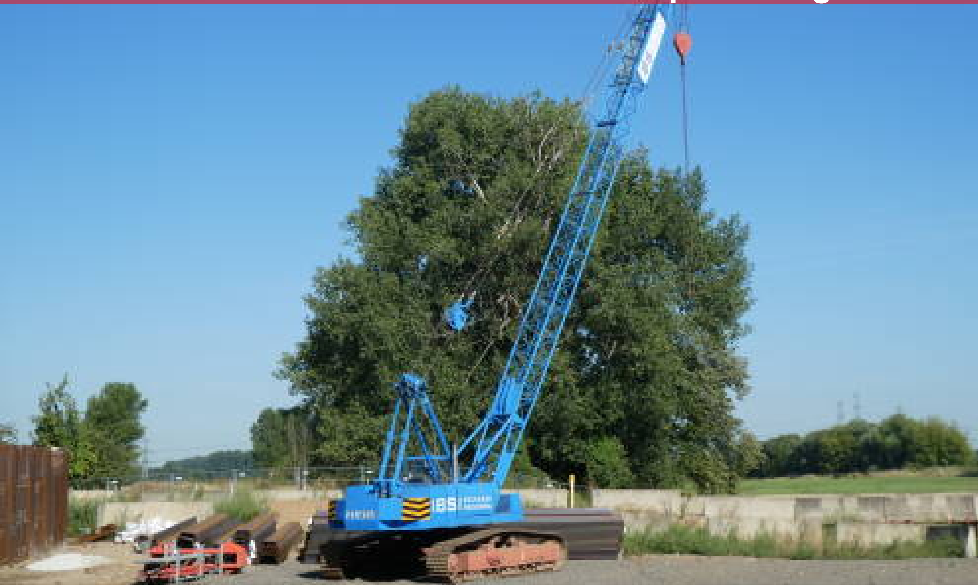
Fuchs 125 im Jahr 2019 im Einsatz beim Bau der Rheinbrücke in Leverkusen
