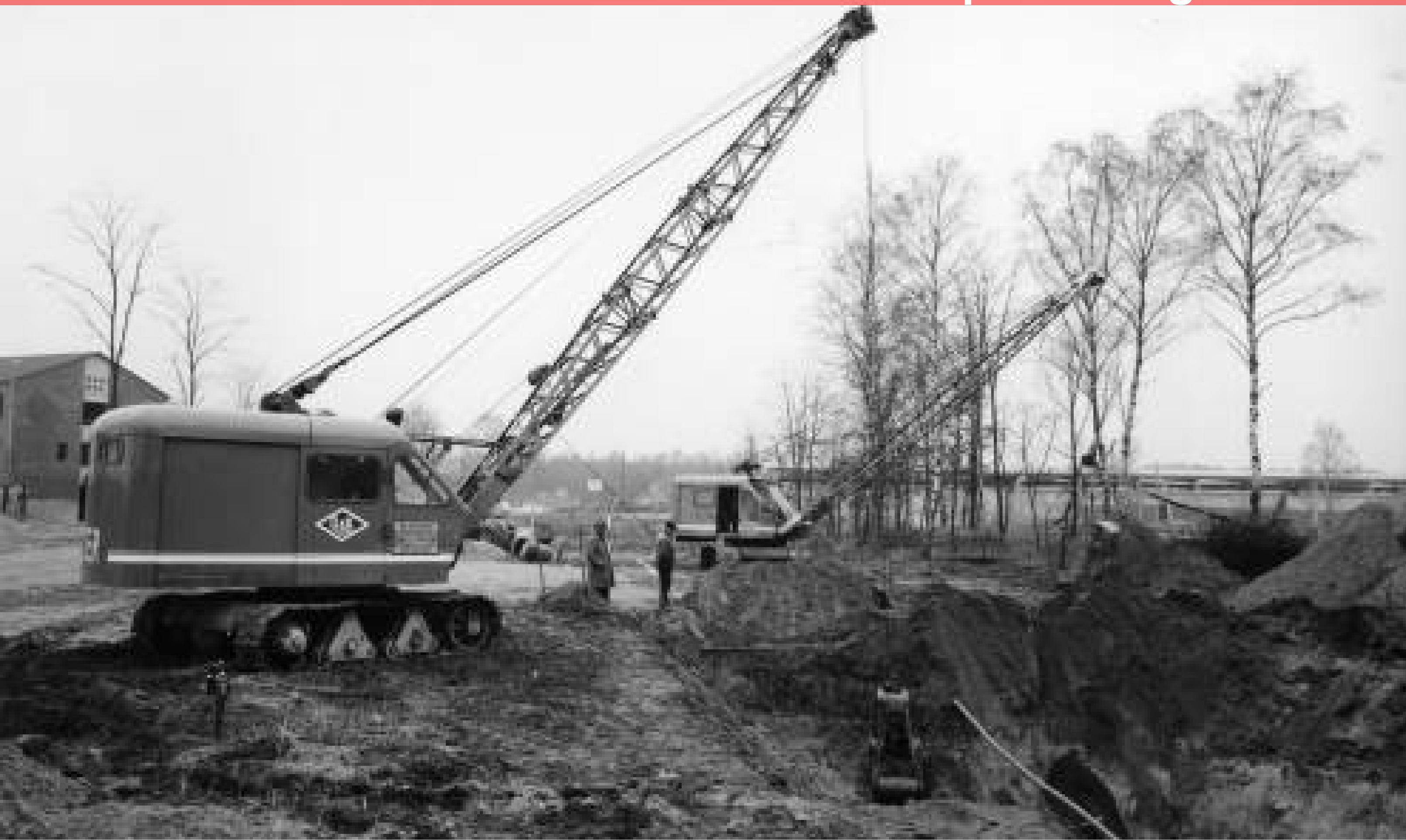
Universal-Raupenbagger R7 mit Griefer- und Schleppeinrichtung auf einer Straßenbaustelle
