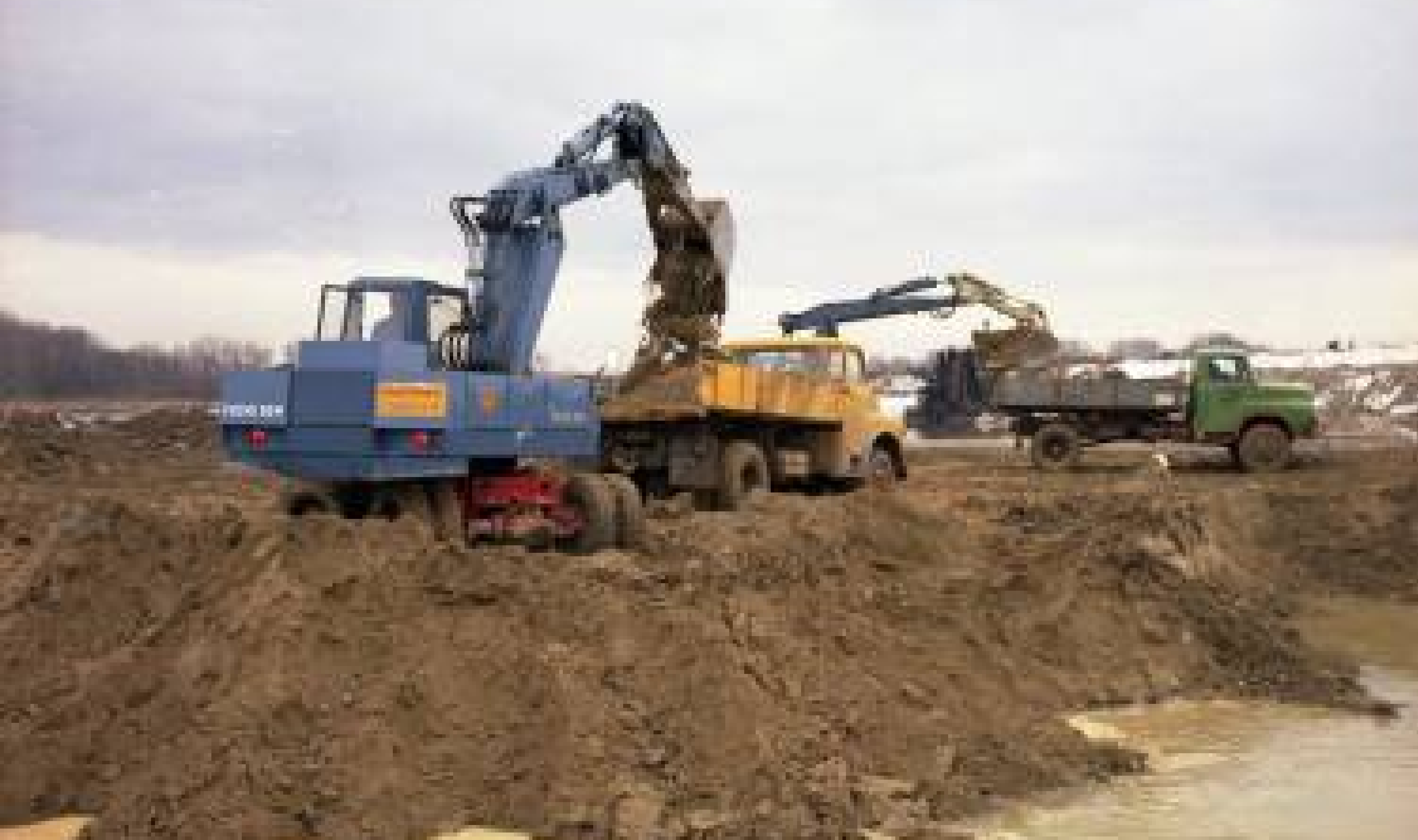
Fuchs 50R und 50M beim Bau des Germersheimer Hafens
