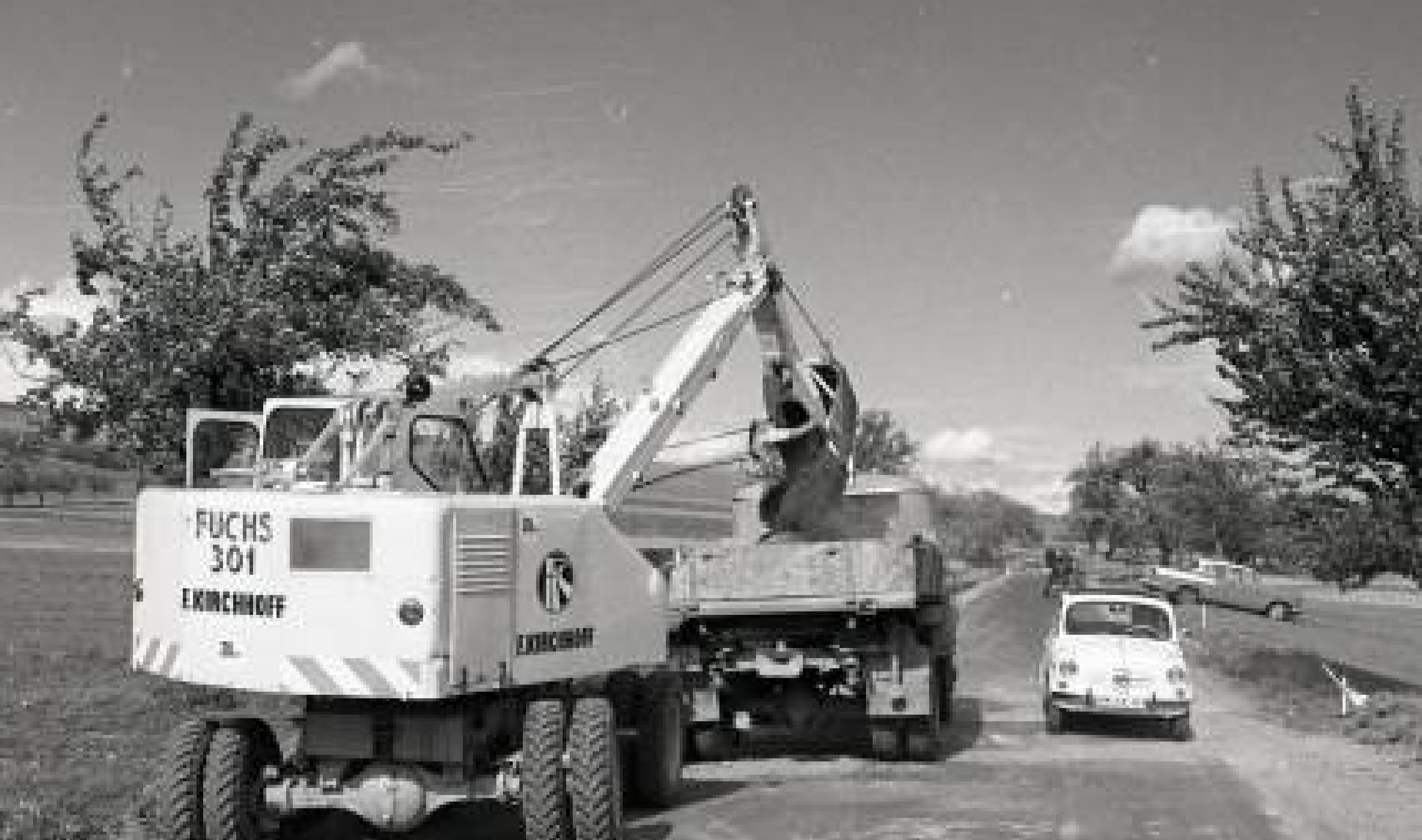
Fuchs 301 auf einer Straßenbaustelle
